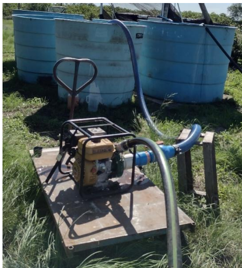
Figura 22: Instalação de motobomba próximo ao reservatório. O autor.
