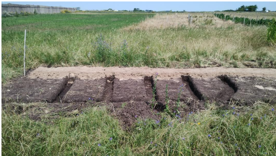
Figura 15: Local nivelado para instalação do politubo. O autor.
