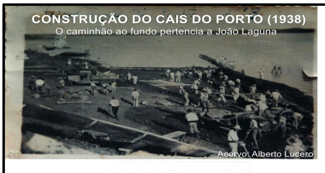
Figura 13: Construção da Ponta da faixa do Porto
