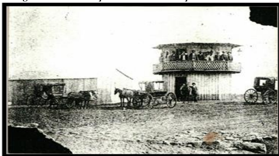
Figura 11: Fiscalização antes da construção do Cais do Porto
