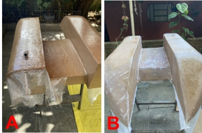
Figura 13 - [A] Aplicação da manta de fibra de vidro; [B] Aplicação do véu de fibra de vidro.
