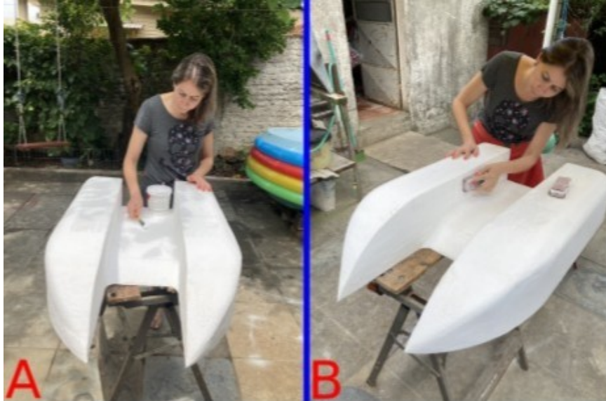
Figura 11 - [A] Aplicação massa tapa furo; [B] Lixamento.
