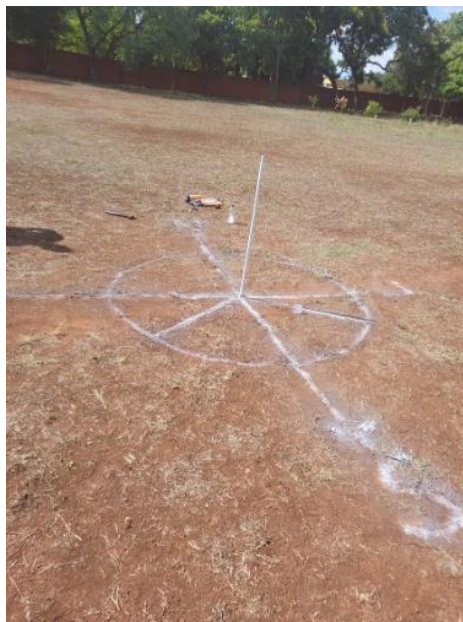
Figura 25 - Passo 7: Fotografia da determinação e da marcação dos 4 pontos cardeais (sul, norte, leste, oeste)
