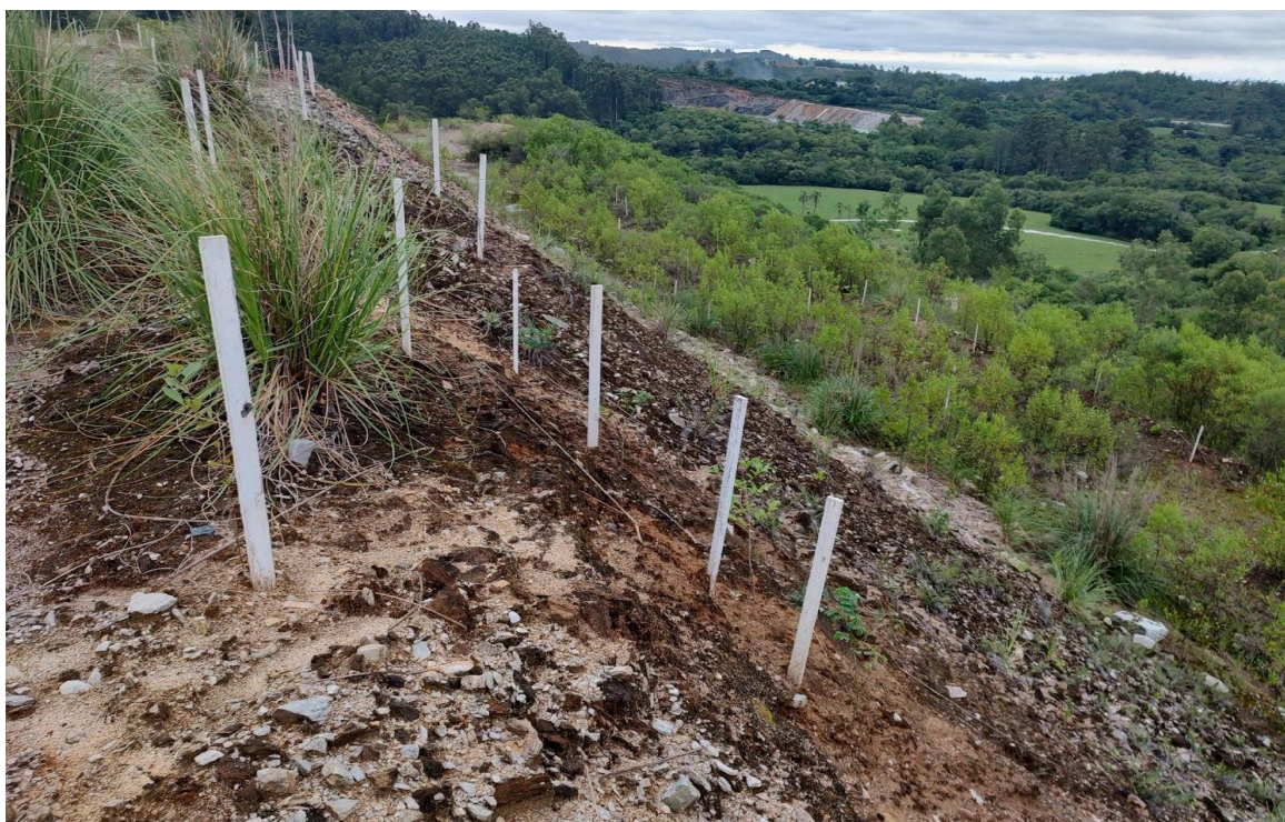
Figura 19 - Modelo de plantio de mudas nativas em talude com processo de recuperação adiantado (Fonte: Autor, 2023).
