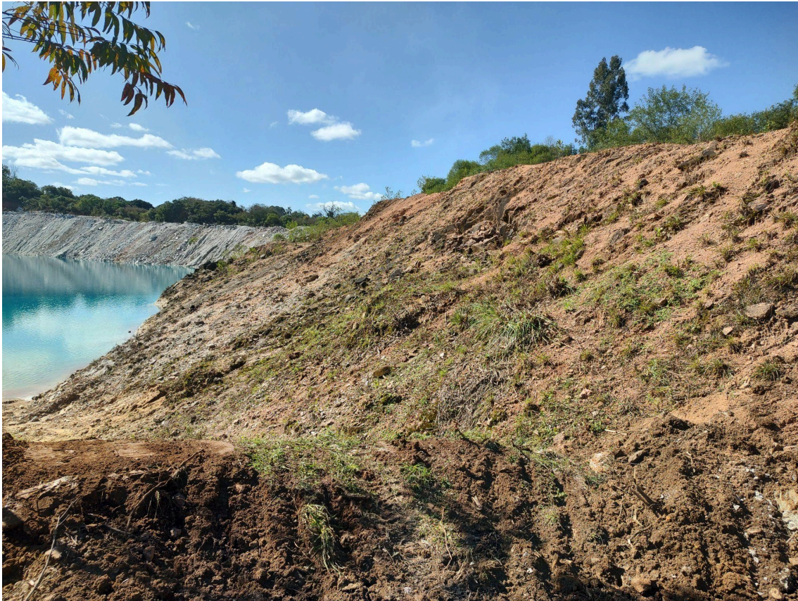
Figura 14 - Disposição de solo para plantio de gramíneas e mudas (Fonte: Autor, 2024).
