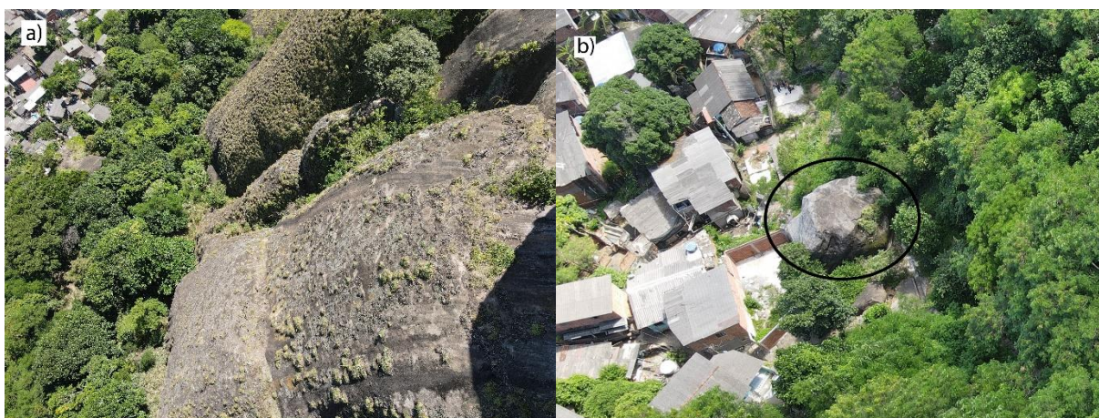
Figura 20 - Imagens obtidas pelo levantamento feito com o drone. a) vertente do maciço com alta inclinação; b) bloco que deslizou em 2016.
