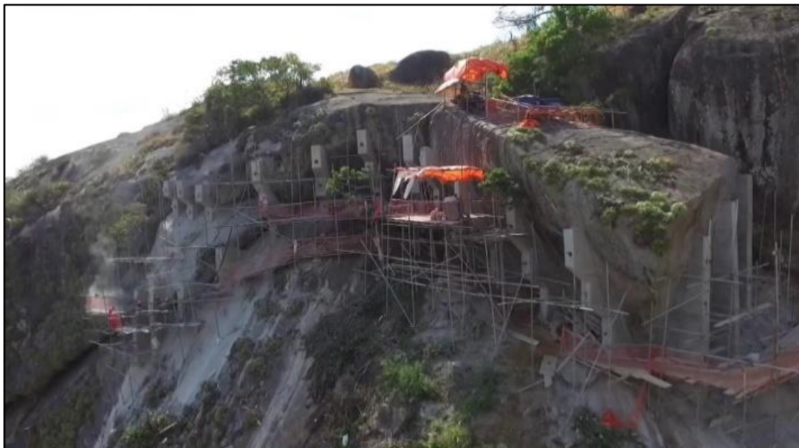
Figura 18 - Obras de contenção de bloco rochoso sendo executado.
