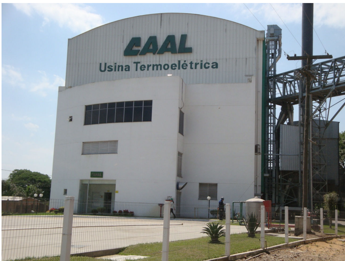
FIGURA 10: Foto da fachada da UTE - CAAL.
