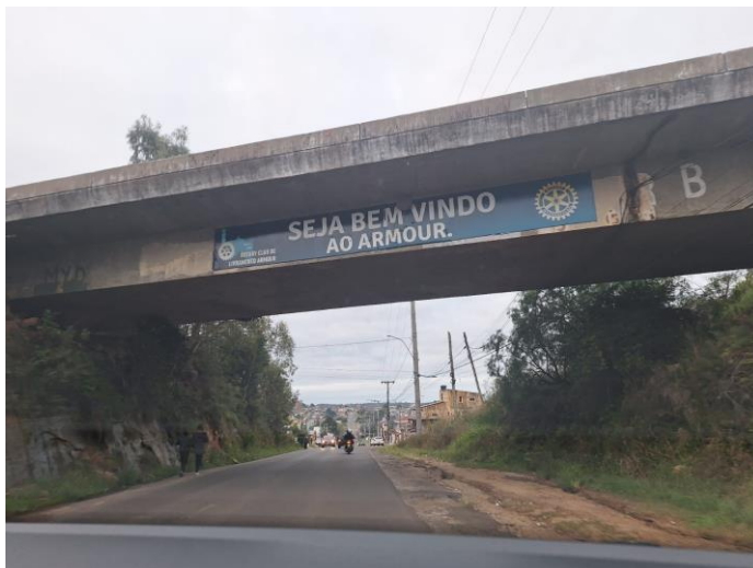
Figura 02: Viaduto do Bairro Armour
