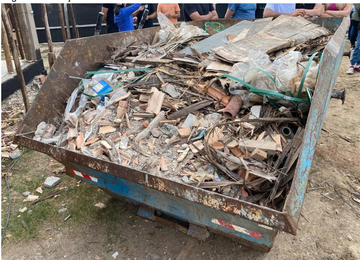
Figura 26 – Caçamba metálica estacionária encontrada em uma das obras visitadas
