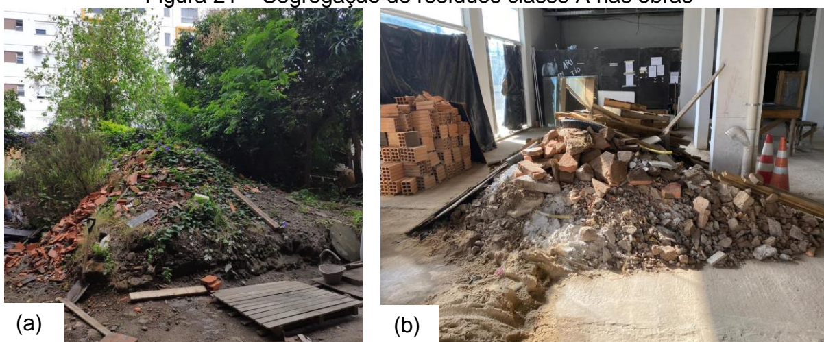
Figura 21 – Segregação de resíduos classe A nas obras
