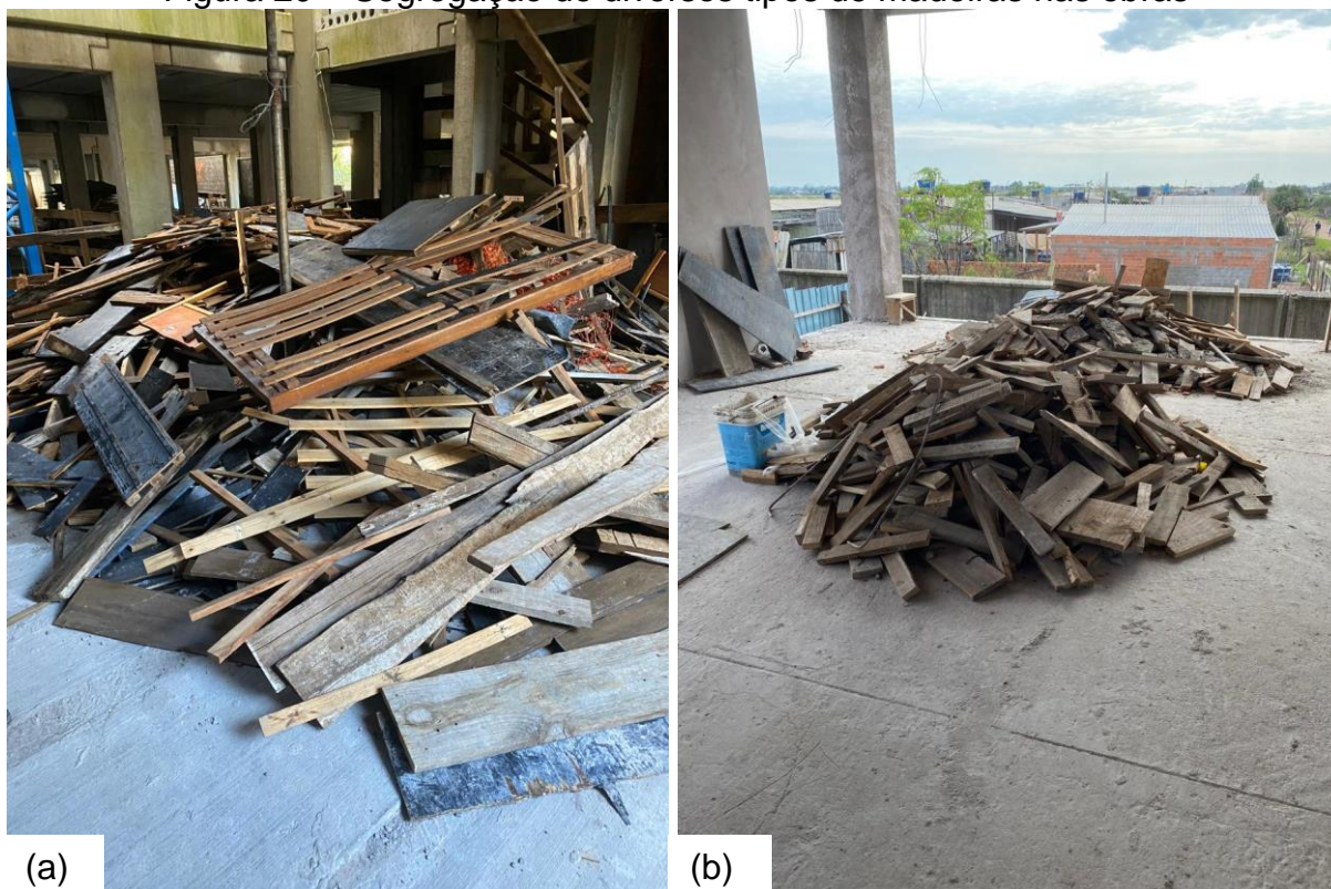
Figura 20 – Segregação de diversos tipos de madeiras nas obras
