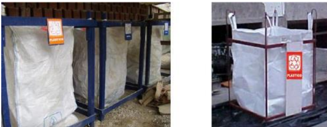
Figura 4 – Exemplo de bags instaladas no canteiro de obra com suportes de madeira e metal
