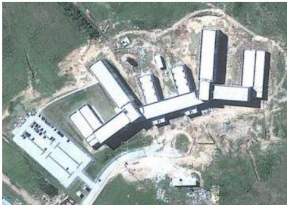
Figura 1 - Instalações da Unipampa Campus Bagé (RS)
