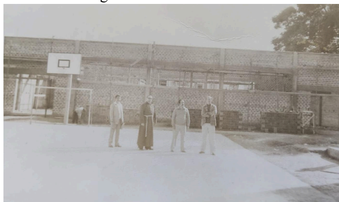
FIGURA 5 - Fotografia durante obras no Ginásio da Escola
