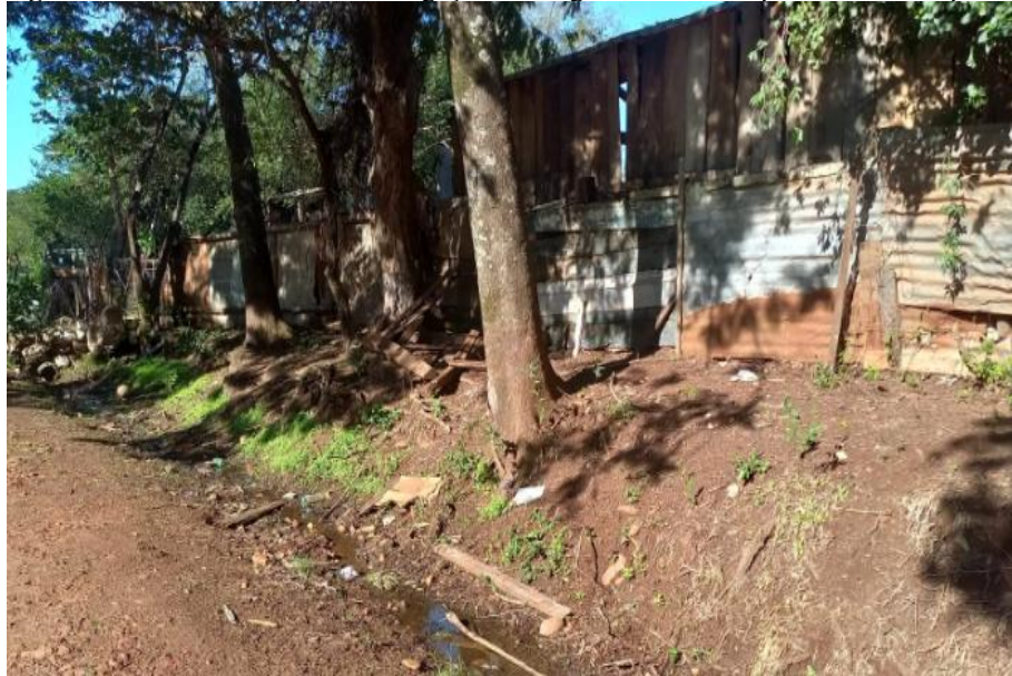
Figura 10: Escoamento pluvial e ligações de esgoto, na vila da praia, bairro do passo.
