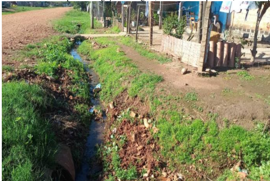
Figura 14: Escoamento pluvial e ligações de esgoto, vila Mario Roque Weis, bairro do passo.
