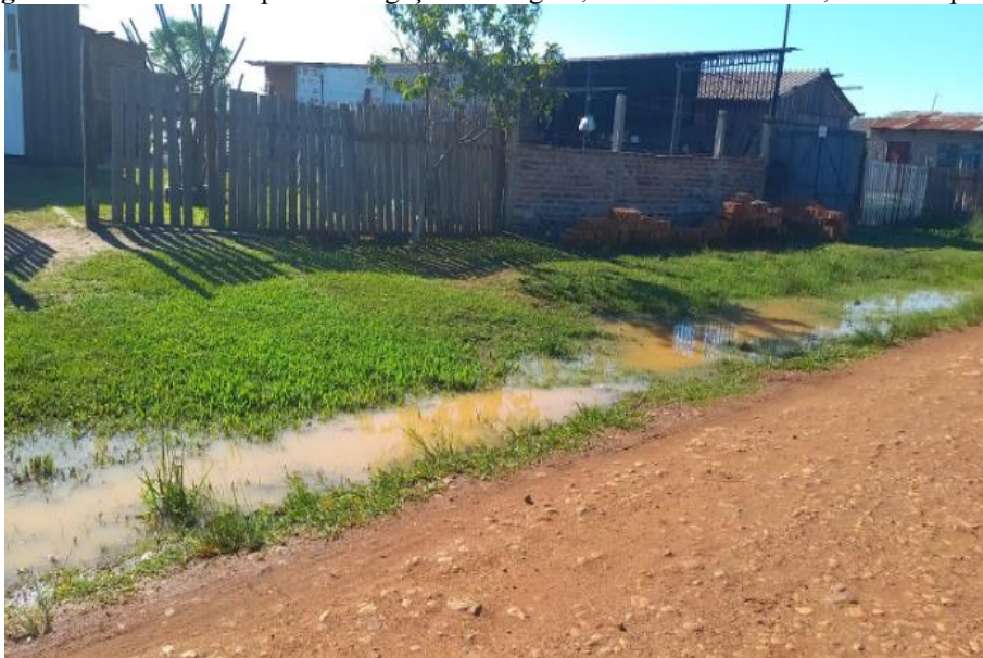
Figura 13: Escoamento pluvial e ligações de esgoto, vila Arneldo Matter, bairro do passo.
