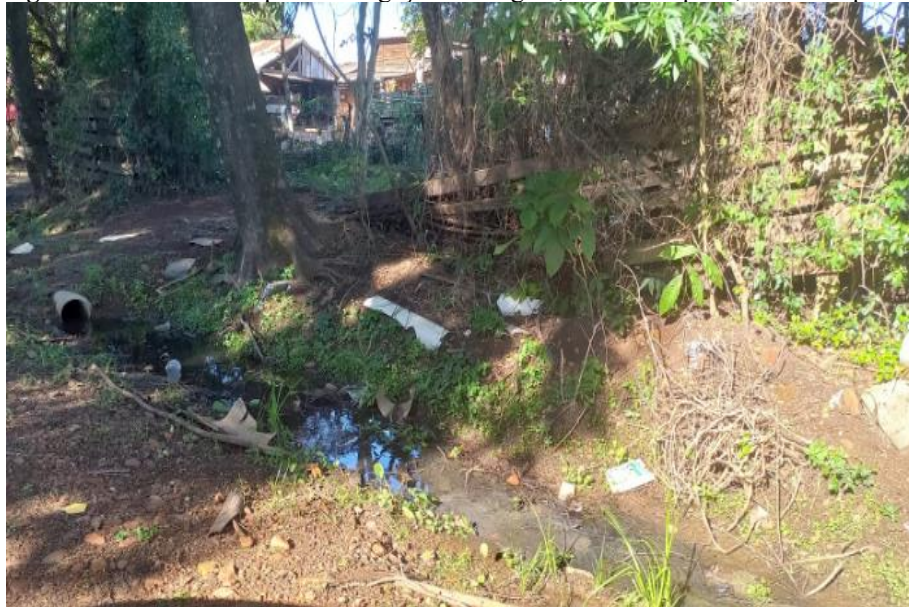
Figura 11: Escoamento pluvial e ligações de esgoto, na vila da praia, bairro do passo.
