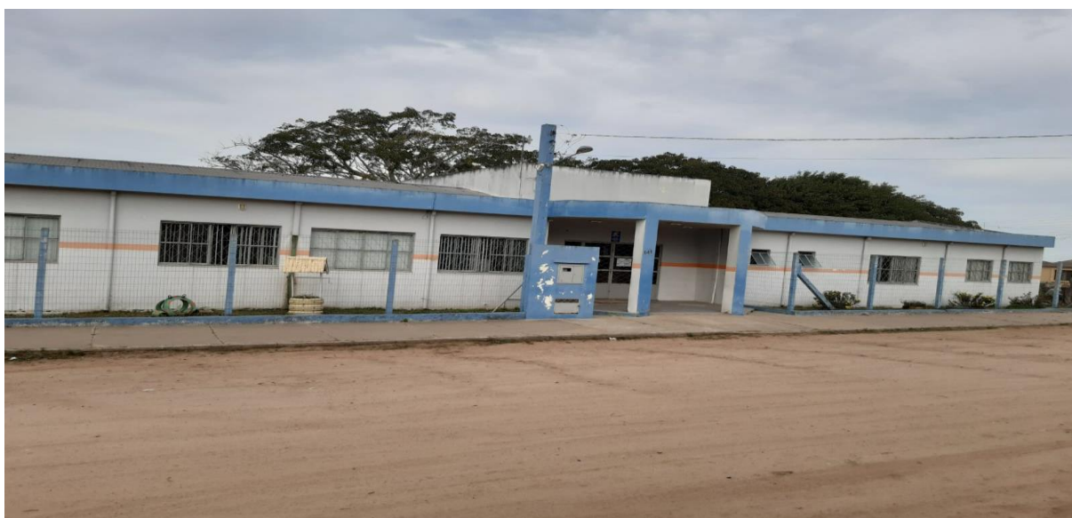
Figura 4 - Foto da UBS do bairro
