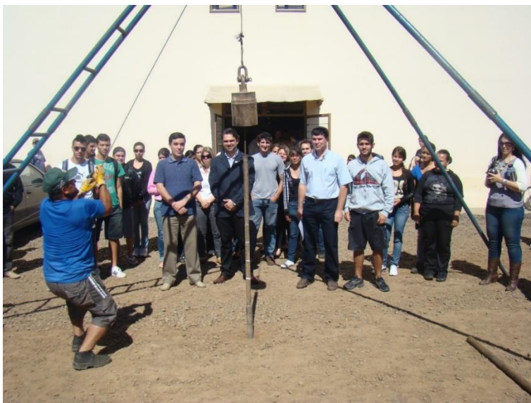
Figura 2 Avaliação da resistência do solo para a construção do prédio Administrativo
