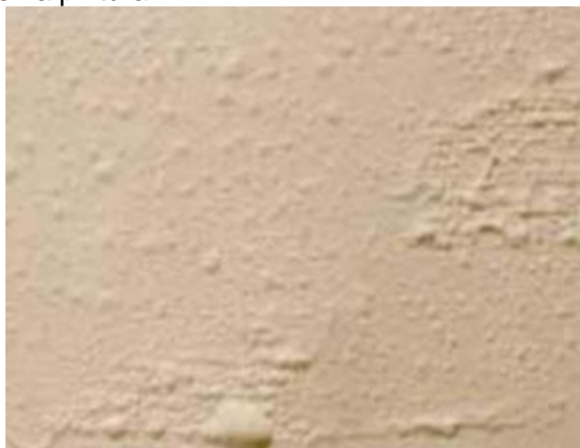
Figura 6 – Bolhas na pintura
