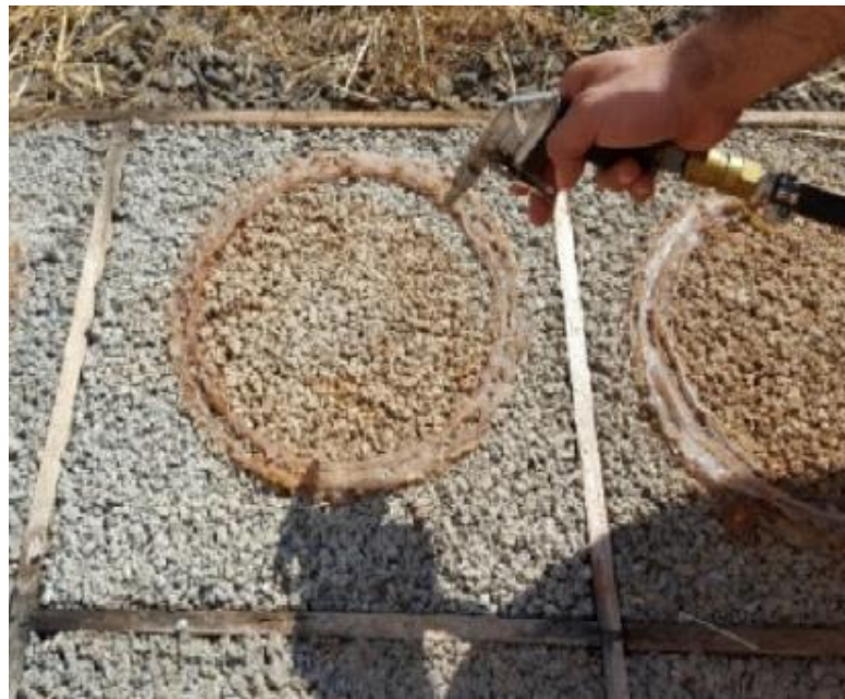
Figura 6 – Limpeza com jato de ar comprimido.
