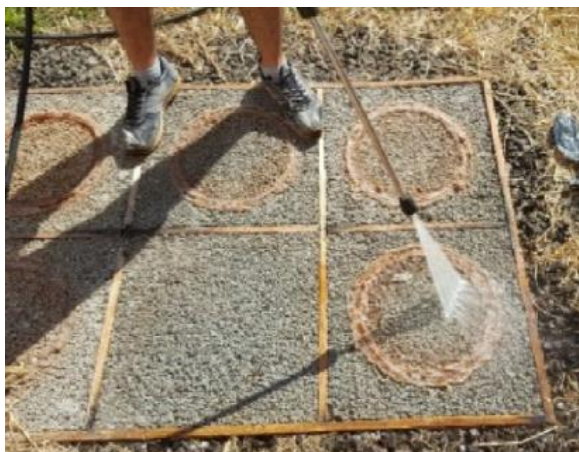
Figura 5 – Lavagem com água de alta pressão.
