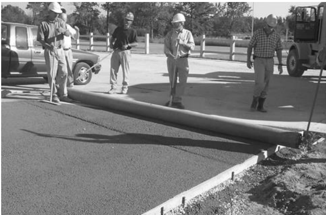
Figura 2 – Compactação do concreto permeável com rolo.
