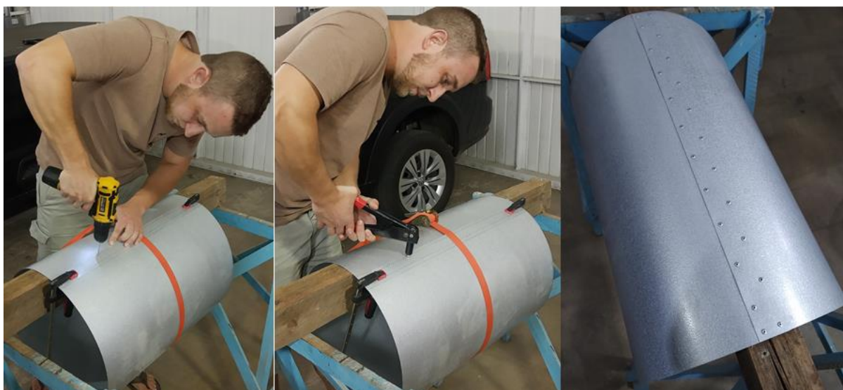
Figura 1. Construção do silo armazenador e fixação com rebites.
