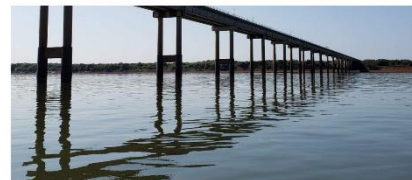
Foto: Ponte Internacional São Borja BR / Santo Tomé AR
