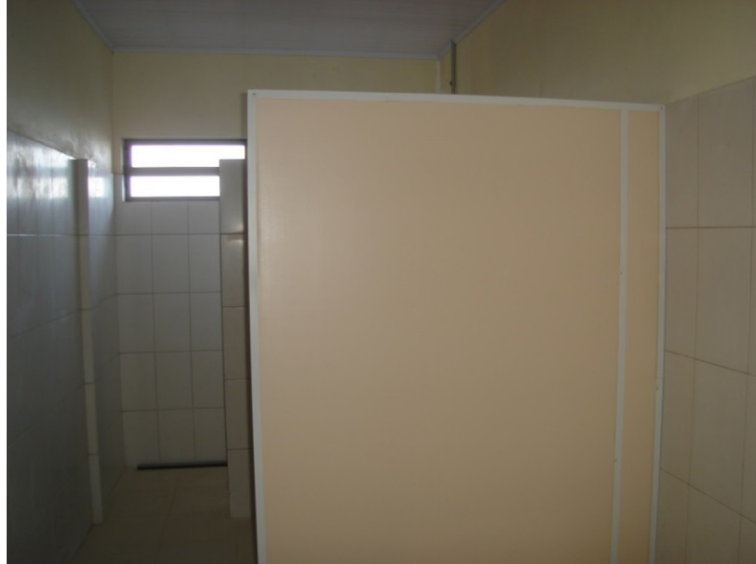
Figura 17 - Divisória de placa cimentícia.
