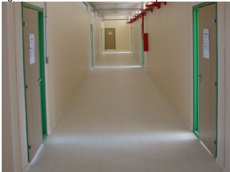
Figura 12 - Piso melamínico da alta pressão instalado.
