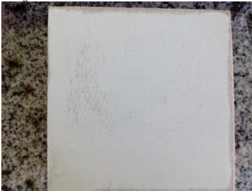
Figura 26 - Lixamento da divisória leve com lixa nº 120.
