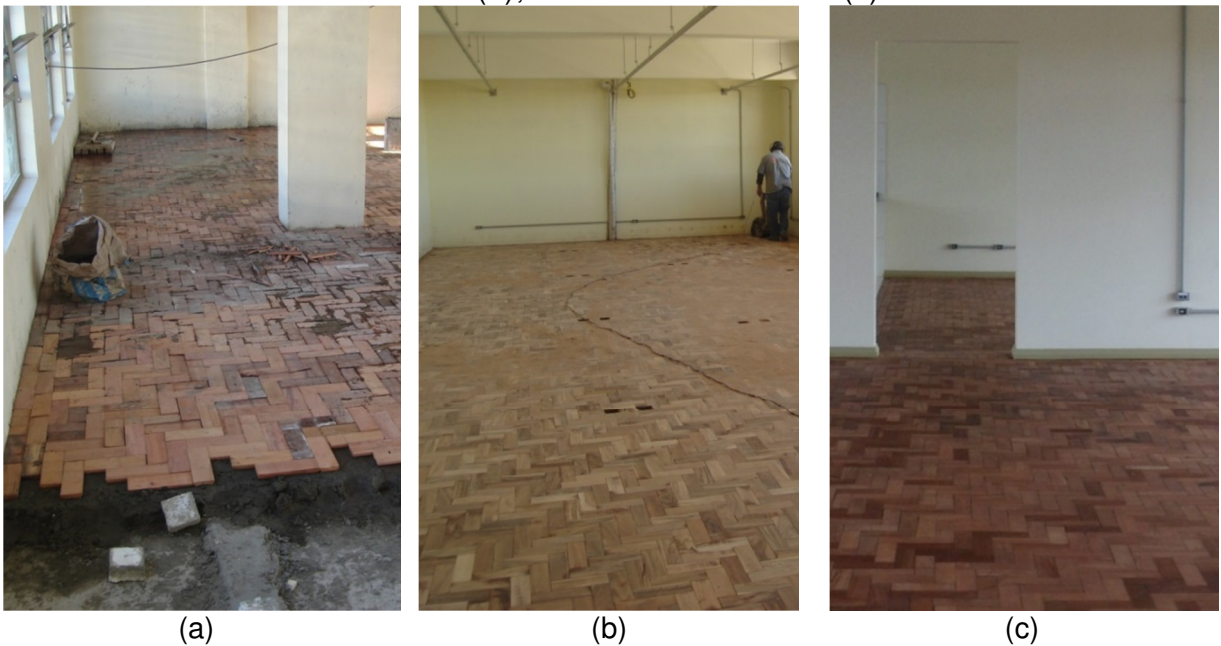
Figura 10 - Etapas de instalação do piso de madeira em taco: assentamento (a); lixamento (b); acabamento em cera (c).
