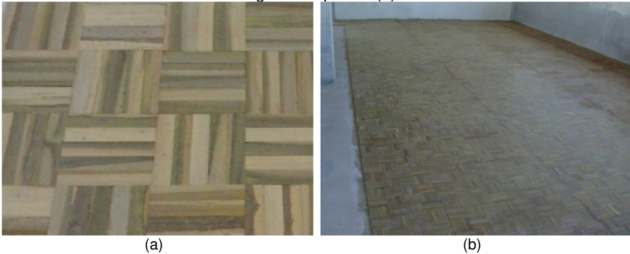
Figura 11 - Piso de madeira em parquet: disposição das lamelas de madeira (a); colagem das placas (b).
