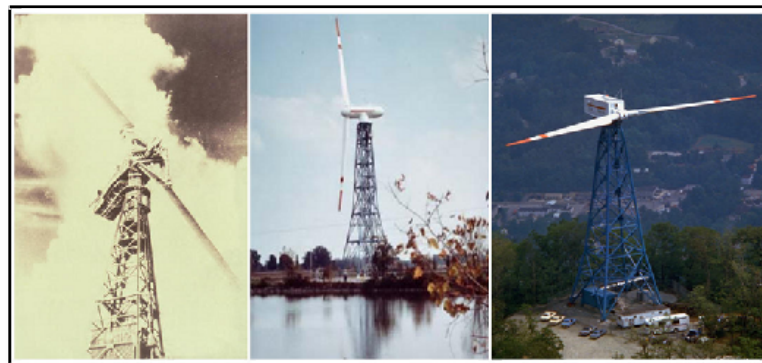
Figura 6- Protótipos Americanos, o Aerogerador de Putnam (Carl Wilcox, 1941) e os Aerogeradores MOD 0 (Martin Brown, 1975) e MOD 1 (NASA, 1979).
