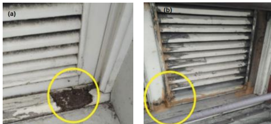
Figura 13 – Detalhamento de manifestações patológicas em esquadrias de madeira
