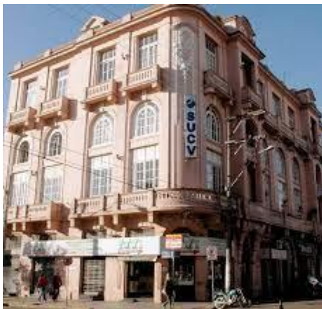
Figura 19 – Fachada do Edifício João Fontoura Borges
