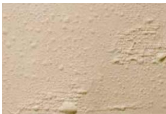
Figura 11 – Superfície exposta a bolhas ou vesículas
