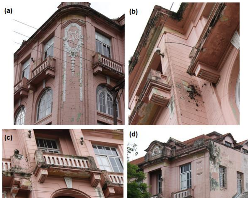
Figura 27 – Registros fotográficos do Edifício João Fontoura Borges
