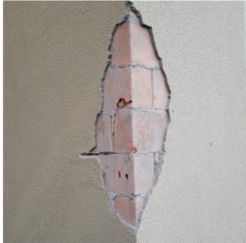
Figura 8 – Detalhe de Desagregação
