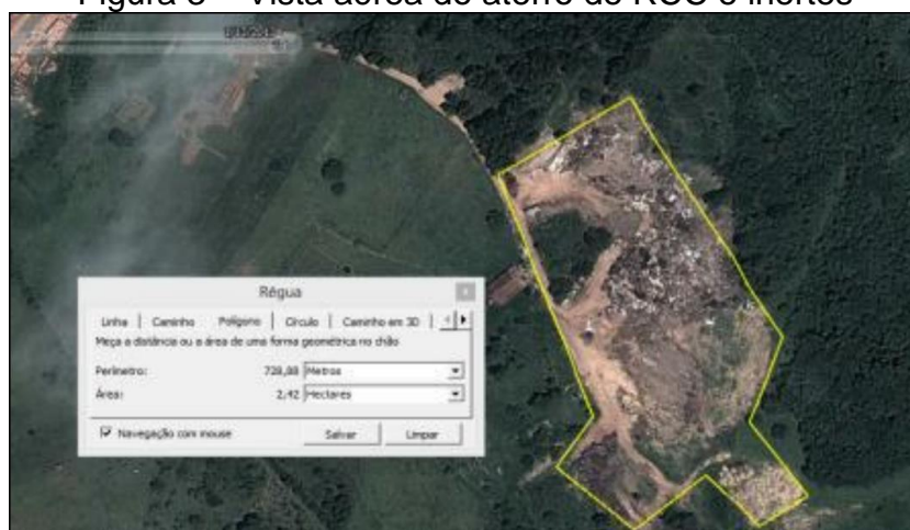
Figura 3 – Vista aérea do aterro de RCC e inertes
