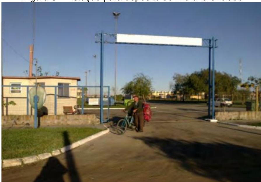
Figura 6 – Estação para depósito de lixo diferenciado
