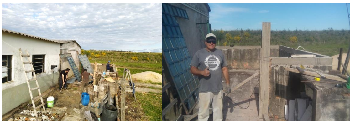
Figura 5. Limpeza e preparação do local.
