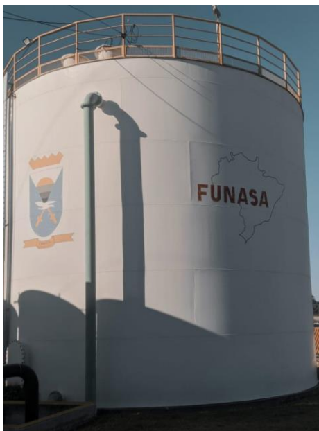
Figura 23 – Reservatório de armazenamento para distribuição
