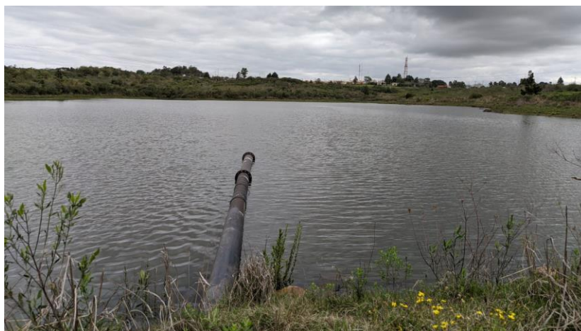
Figura 18 – Captação da água bruta
