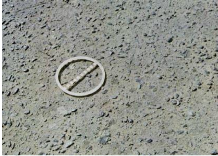
Figura 16 - Superfície de rolamento om desgaste superficial.
