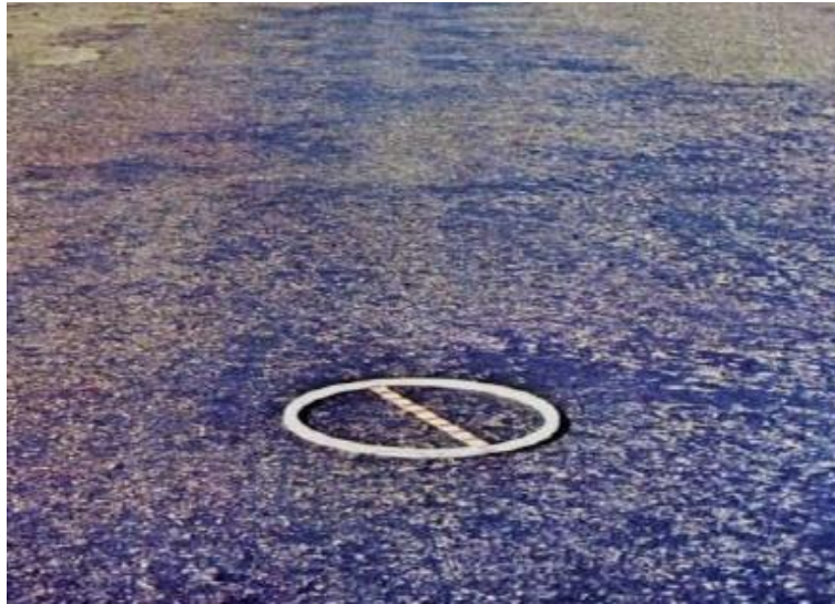
Figura 15 - Superfície de rolamento com exsudação.
