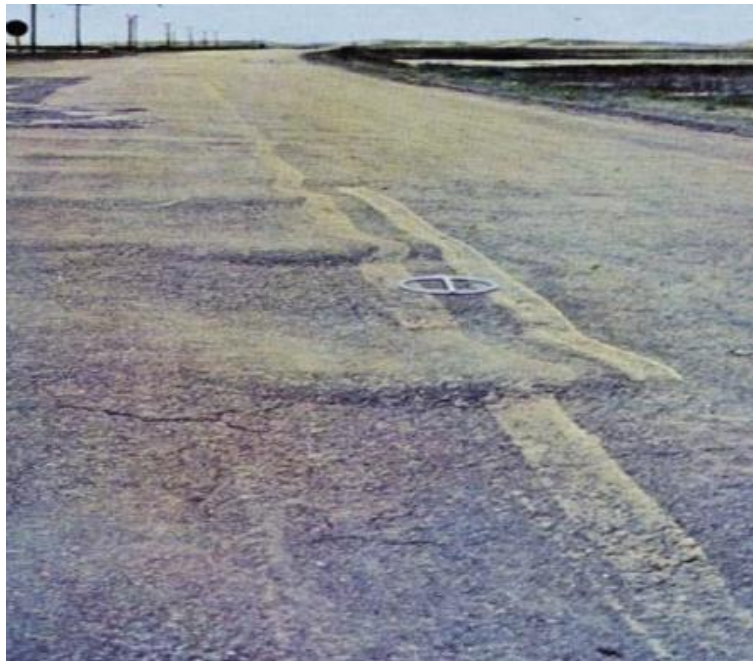
Figura 13 - Superfície de rolamento com ondulações.
