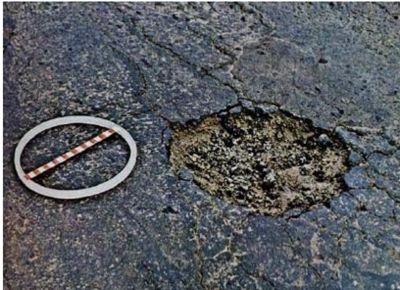
Figura 17 - Superfície de rolamento com panela.
