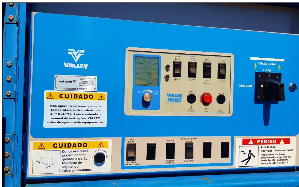
Figura 6 - Imagem do painel de comando do pivô central. Fonte: MARQUES (2022).
