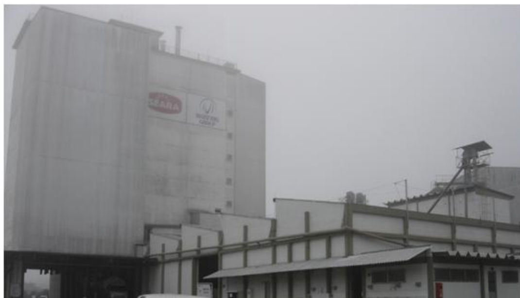
Figura 7 – Fachada da fábrica de ração
