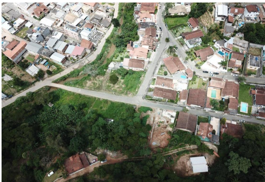
Figura 3- Vista aérea do Loteamento do Barão em fevereiro de 2020, expondo o córrego Dantas e área residencial ainda comprometida após desastre de janeiro de 2011.
