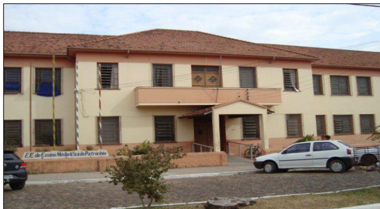
Figura 1: Fachada atual da Instituição. Fonte: Facebook da Escola.
