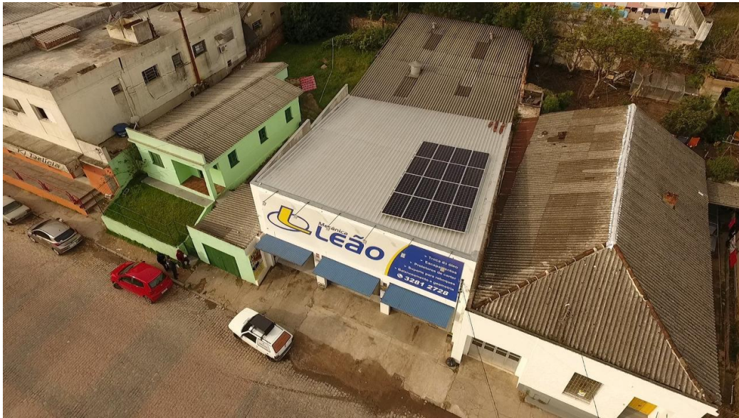
Figura 10 – Imagem mostrando as placas solares no telhado da oficina.
