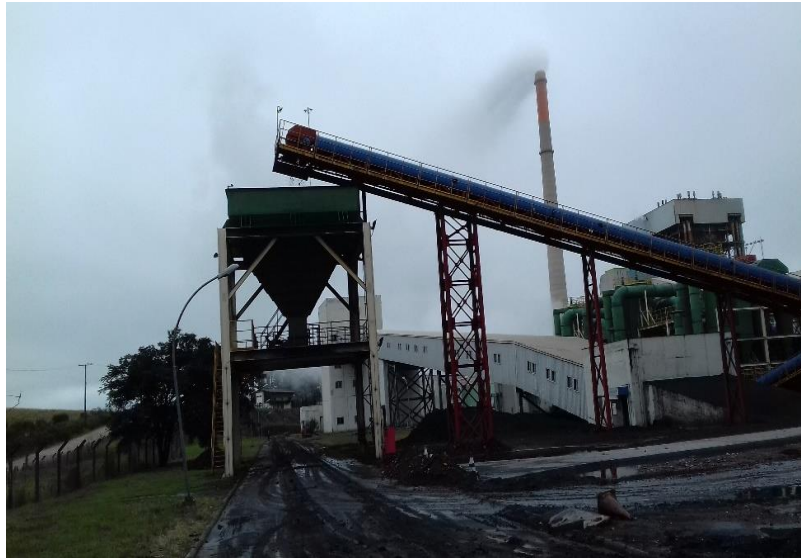
Figura 21 - Correia transportadora de resíduos.
