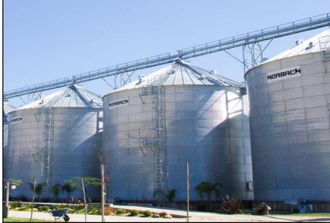
Figura 3 - Silo metálico de fundo plano.
