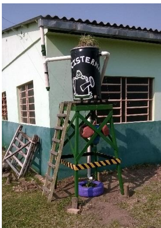
Figura 3: Cisterna utilizada para captar água da chuva.
