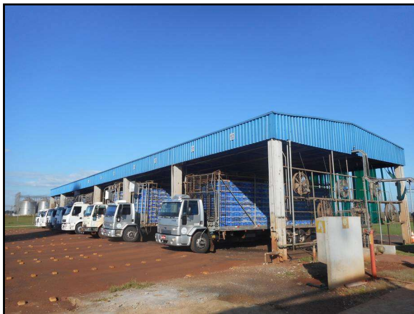
FIGURA 2 - Galpão de espera coberto com sistema de ventilação, nebulização e chuveiro superior (Fonte: Autor)
