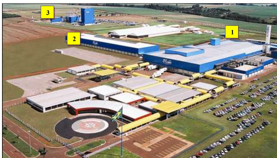
FIGURA 1 – Vista aérea do complexo industrial avícola (1 – Abatedouro de aves; 2 – Indústria de termoprocessados; 3 – Fábrica de rações).
