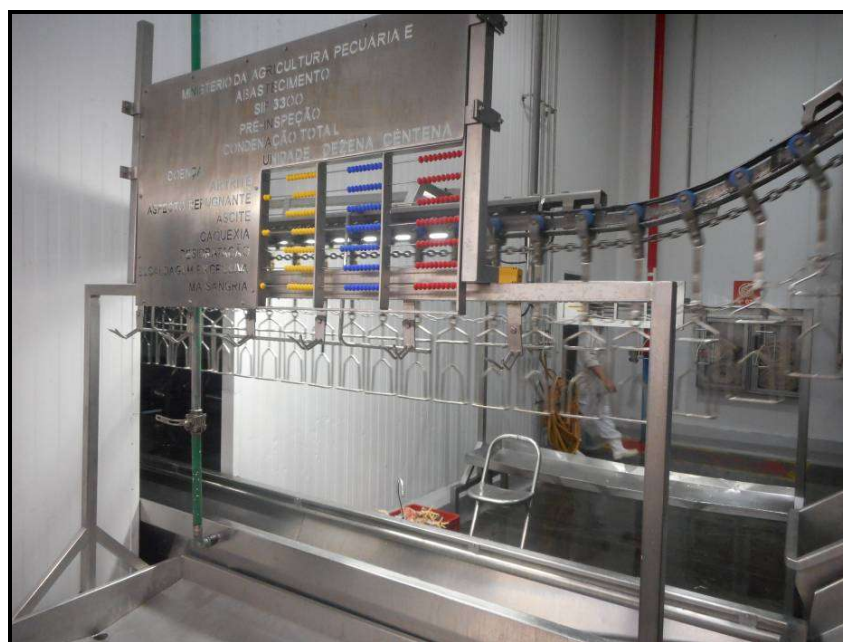
FIGURA 7 - Serviço de pré-inspeção (Fonte: O Autor).
