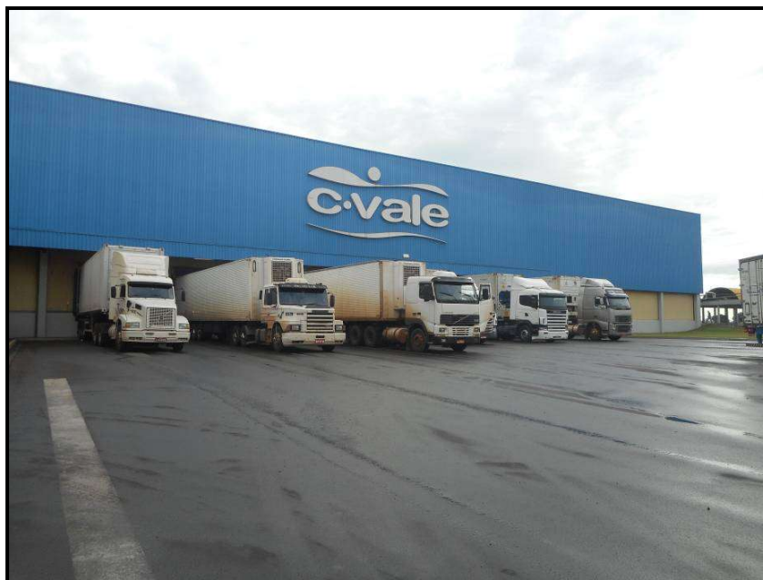
FIGURA 20 - Vista externa das docas de expedição (Fonte: O Autor).
