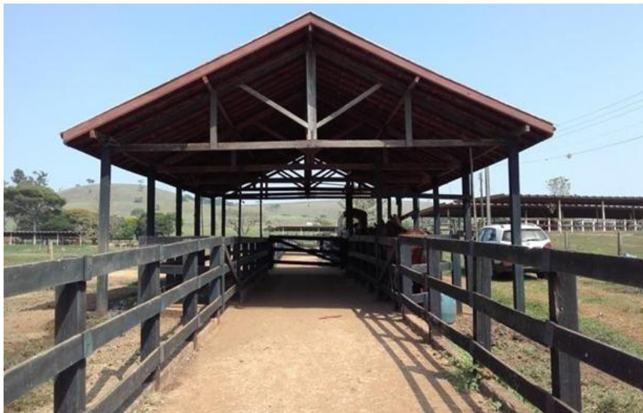
FIGURA 3 - Tronco de contenção destinado aos procedimentos das receptoras.
