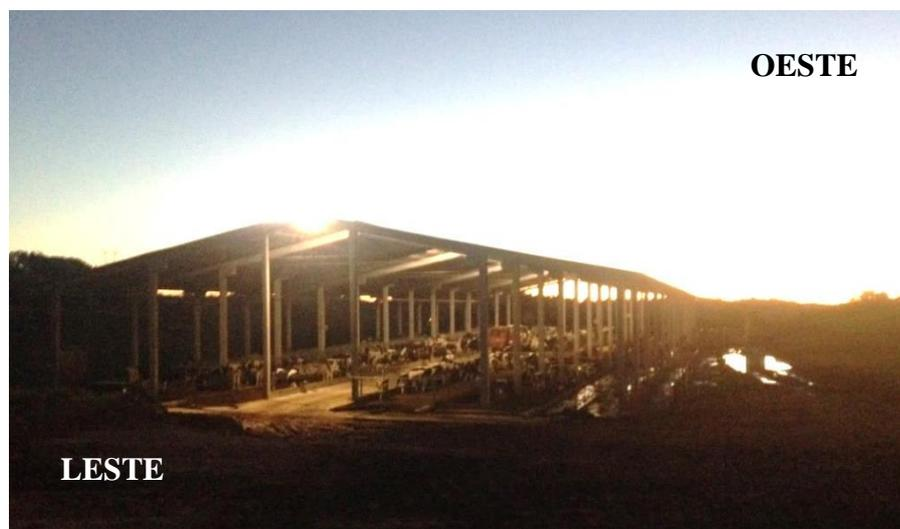
**FIGURA 2** - Representação da orientação correta do galpão *free-stall*, leste para oeste, seguindo a disposição do sol.
