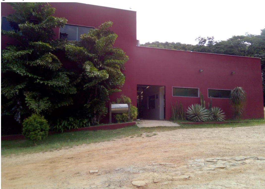
Figura 8 – Imagem fotográfica do Hospital Veterinário Vetcheck – Medicina e Cirurgia Equina, Betim – MG
