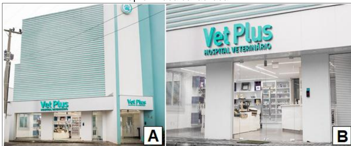
Figura 6 - Hospital Veterinário Vet Plus: (A) Visão ampla da fachada; (B) Visão aproximada da fachada
