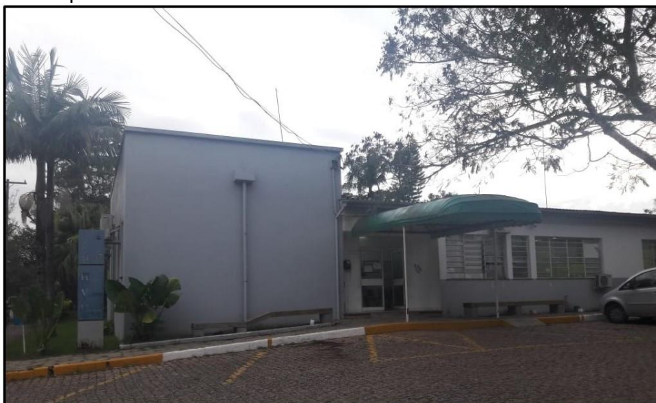
Figura 11 - Hospital Universitário Veterinário UFSM. Fachada
