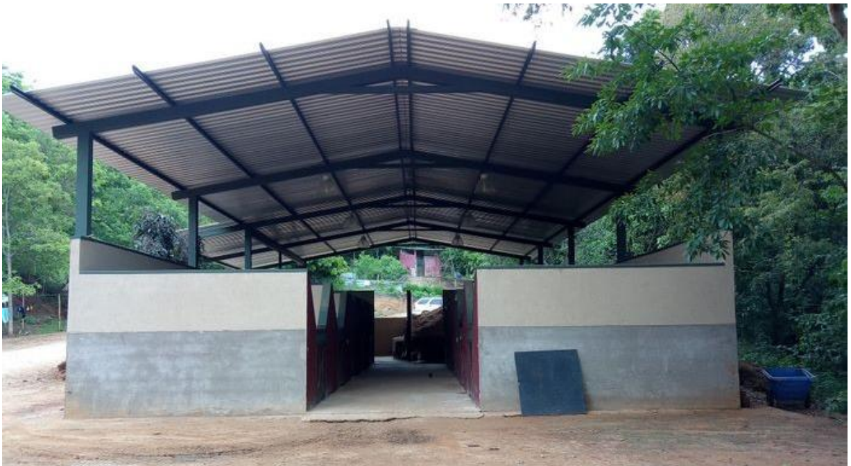
Figura 13 - Quarto prédio contendo baias de internação e depósito para serragem no Hospital Vet Check - Cirurgia e Medicina Equina LTDA - Betim/MG.
