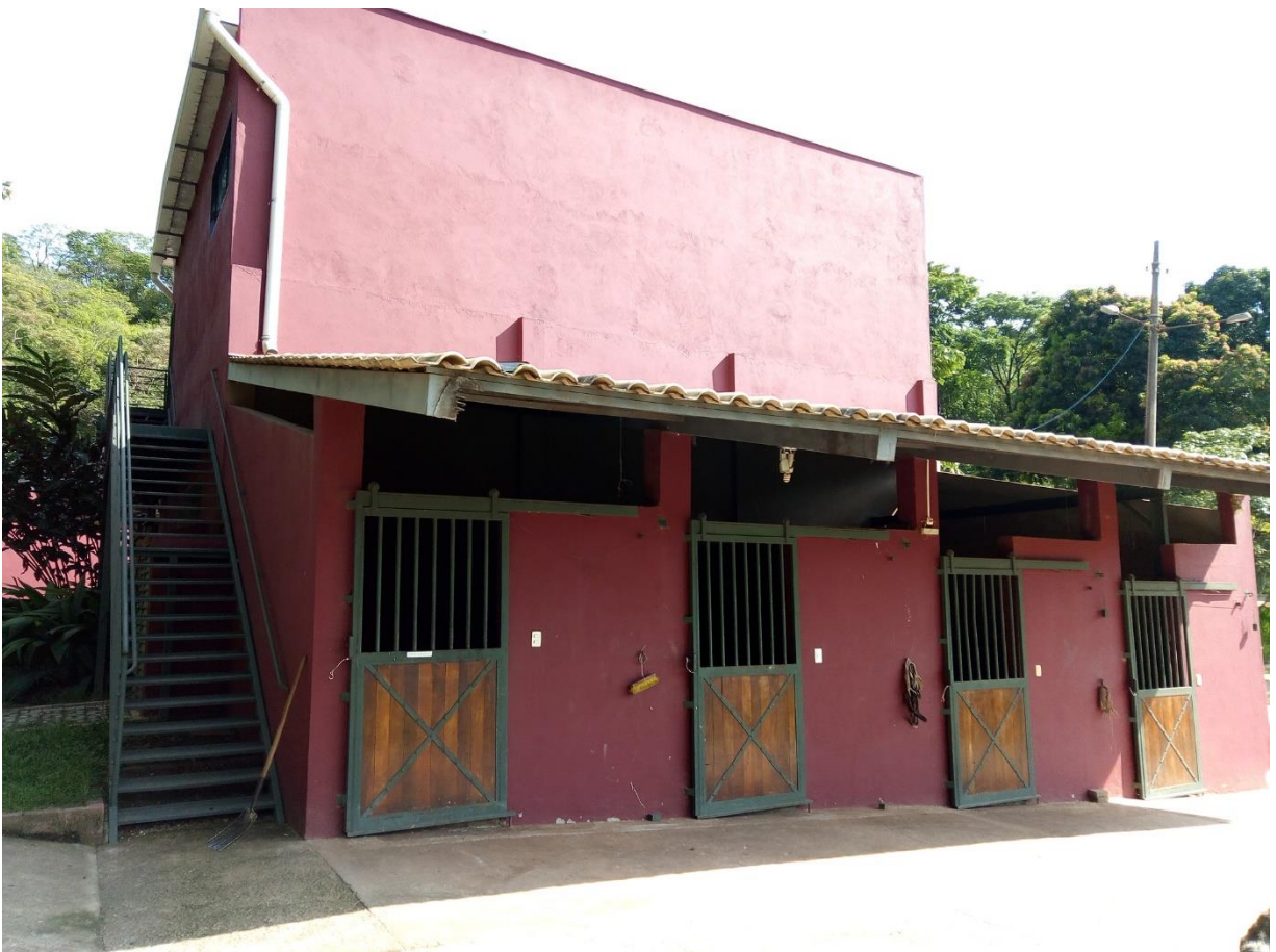
Figura 11 - Baias de internação e escada de acesso ao laboratório e auditório no Hospital Vet Check - Cirurgia e Medicina Equina - Betim/MG.
