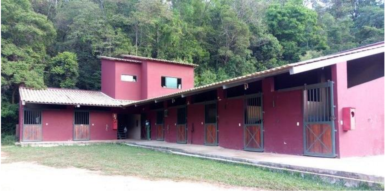
Figura 12 - Baias de internação e alojamento para estagiários no segundo pavimento do terceiro prédio no Hospital Vet Check Cirurgia e Medicina Equina LTDA - Betim/MG.
