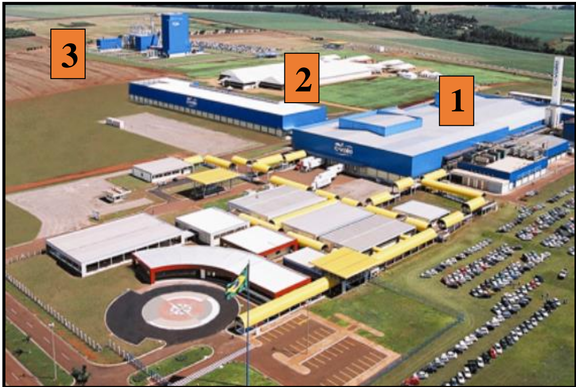
FIGURA 1 - Vista aérea do Complexo Industrial Avícola 1 – Abatedouro de aves; 2 – Indústria de Termoprocessados; 3 – Fábrica de Rações (Fonte: C. Vale 2018).
