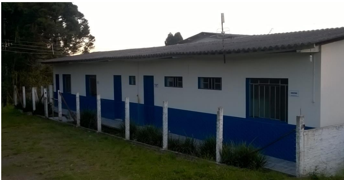
FIGURA 3: Prédio onde se localizam vestiários e barreira sanitária.
