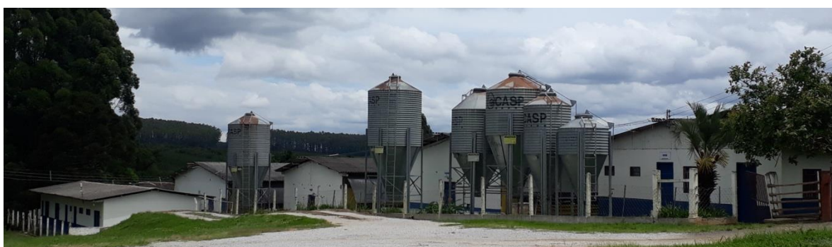
FIGURA 2: Foto da estrutura geral da granja.
