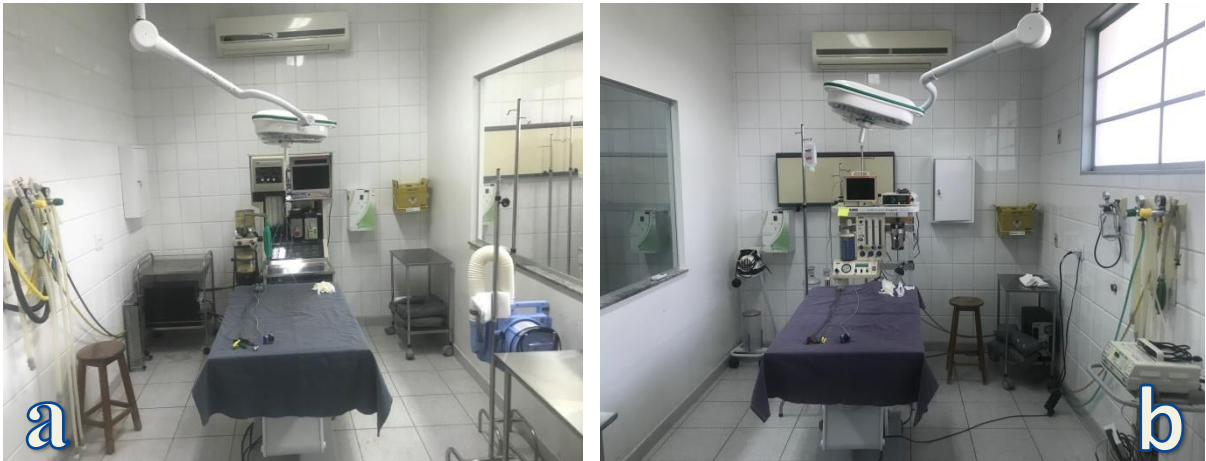
FIGURA 9: Fotografia Sala de Cirurgia Contaminada (esquerda), Sala de cirurgia não contaminada (direita), do Centro Cirúrgico do Setor de Pequenos Animais do HV- GLN da UNESP, Jaboticabal-SP.
