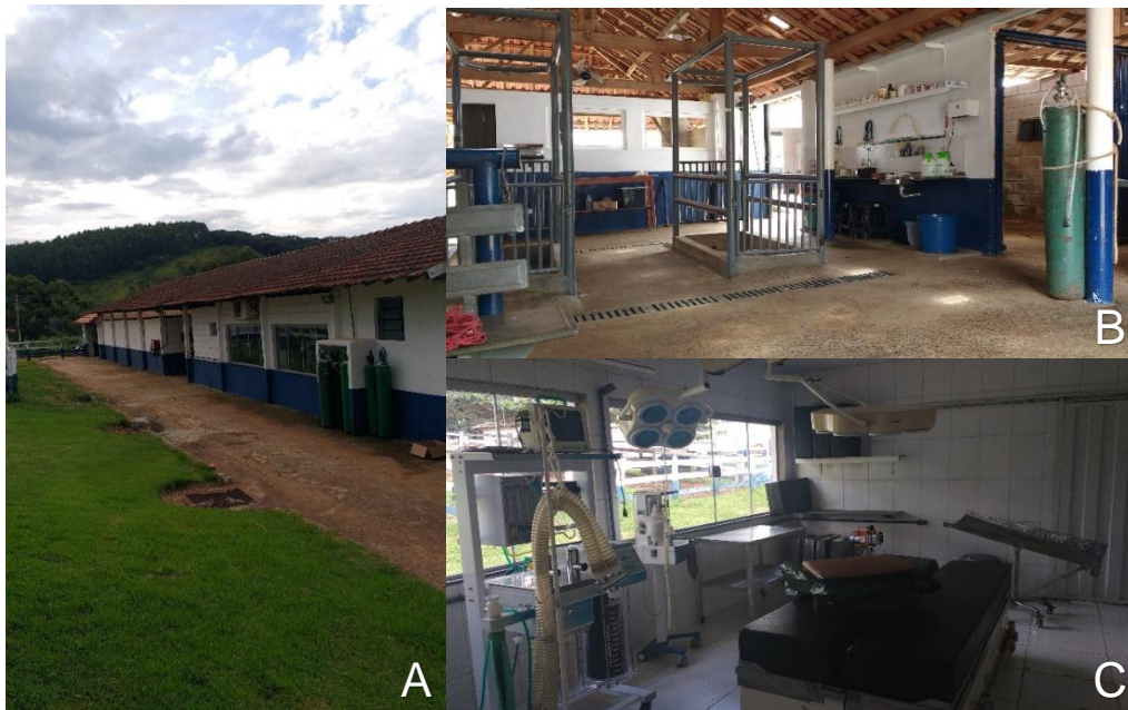
Figura 1 - Frente do pavilhão (A), a área de recepção (B) e o bloco cirúrgico (C) do Centro Médico de Cavalos – CMC. Fonte: Arquivo pessoal.
