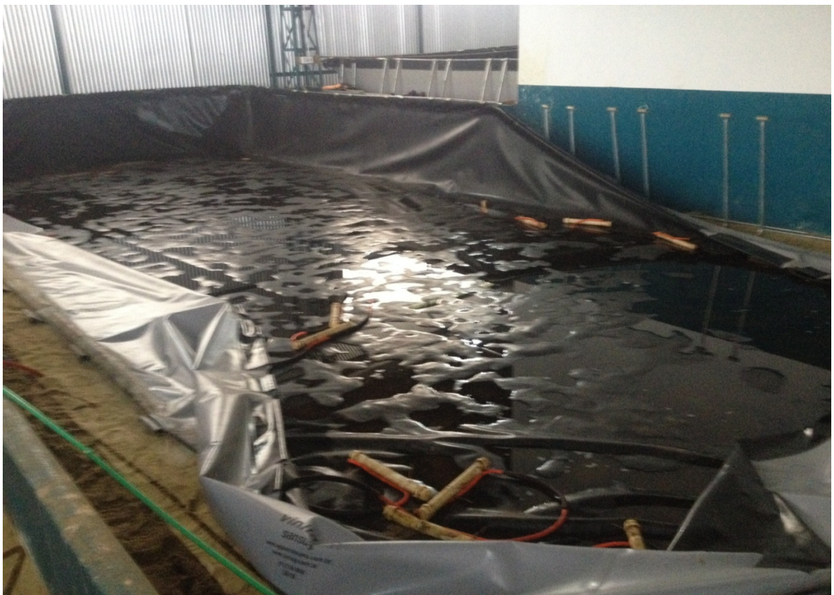
FIGURA 8 - Tanque de vinilona sendo montado na estrutura após passar por reparos.
