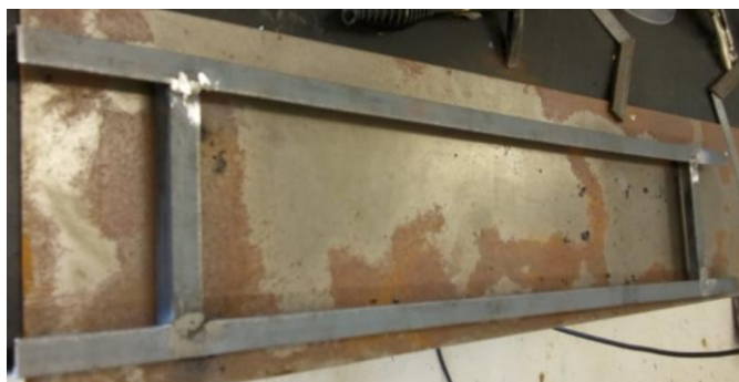
Figura 15 - Estrutura base ponte rolante
