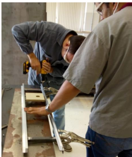
Figura 16 - Fixação do perfil de alumínio
