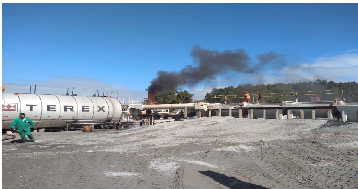
Figura 4 – Usina de asfalto de Caçapava do Sul em funcionamento
