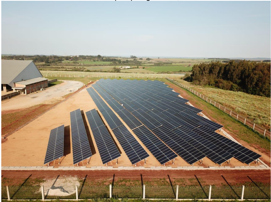
Figura 1 – Usina Solar Fotovoltaica nos pampas gaúchos, São Gabriel – RS
