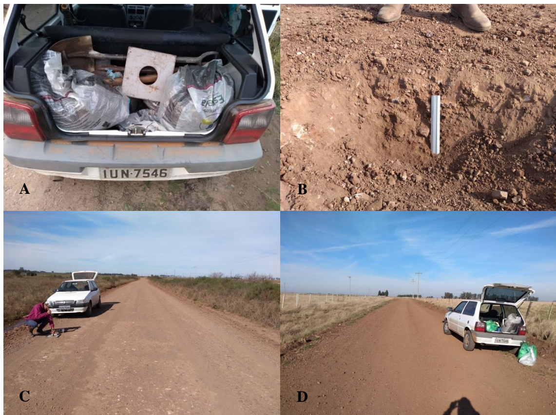
Figura 7 - Análise do Revestimento Primário. A) Amostras acondicionadas. B) Vista da trincheira no ramo 1 da estrada do Silvestre. C) Representação do local da pista analisado. D) estrada do Angico ramo 2.
