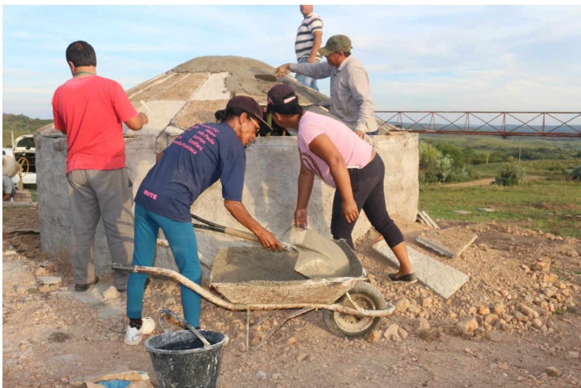
Figura 6- Construção de cisterna em mutirão
